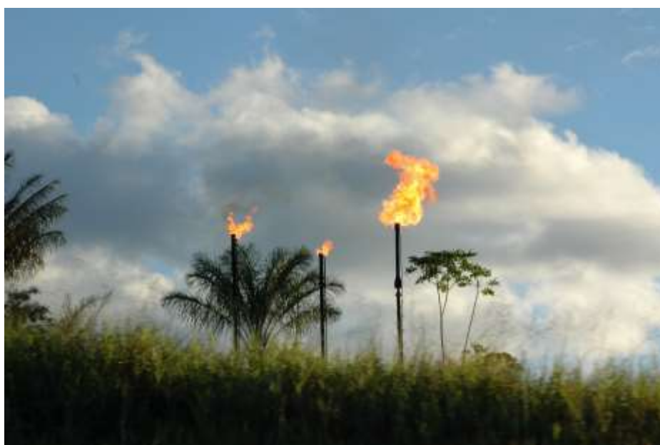
Image 1 : photo prise par l'auteure - torchère Estación de bombeo Sucumbíos, Pacayacu (27/05/13)
