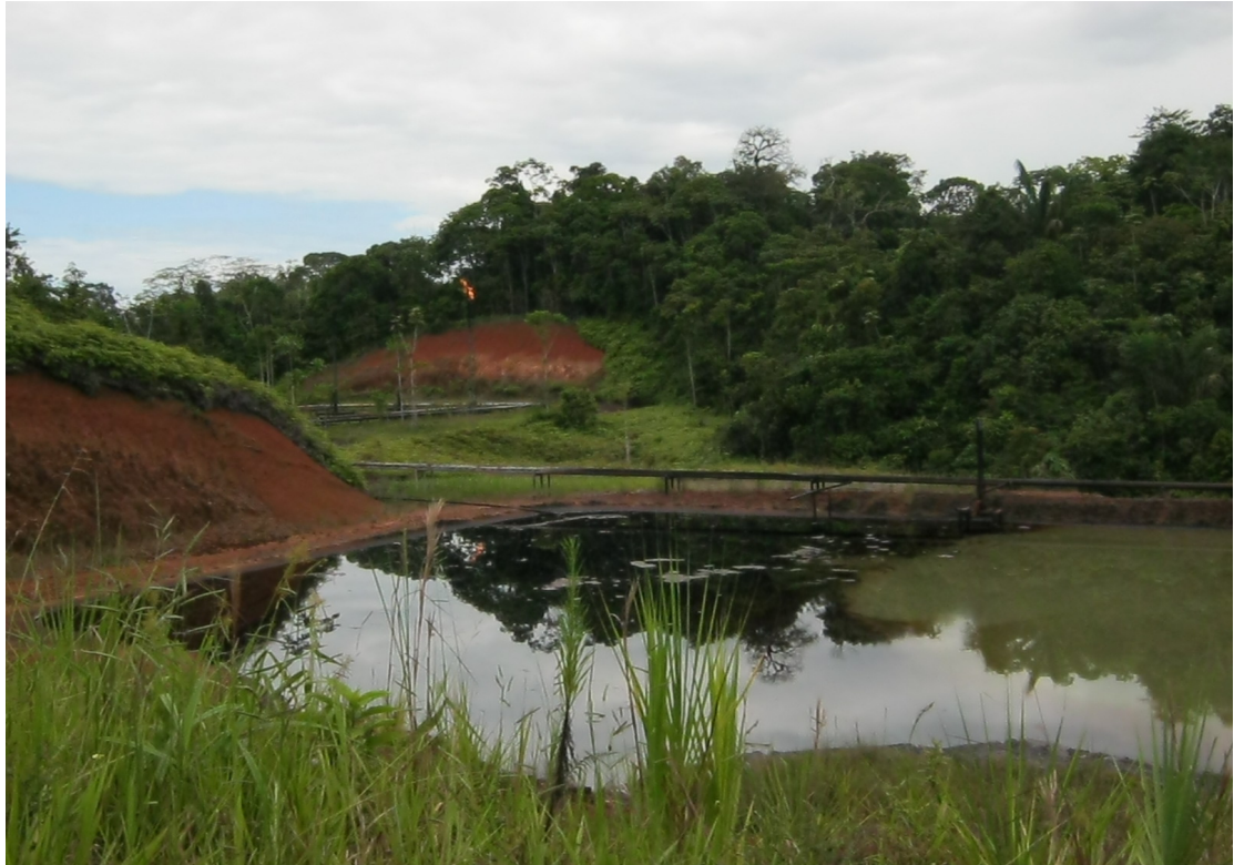
Fosse de stockage des résidus d'exploitation, Pakayaku
